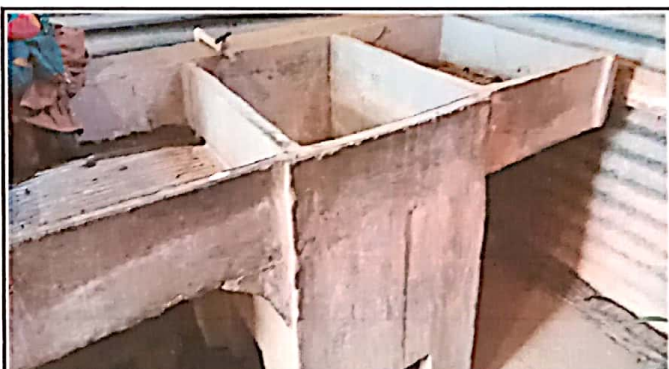
Foto 6: Sustrucción de pila de dos lavaderos
