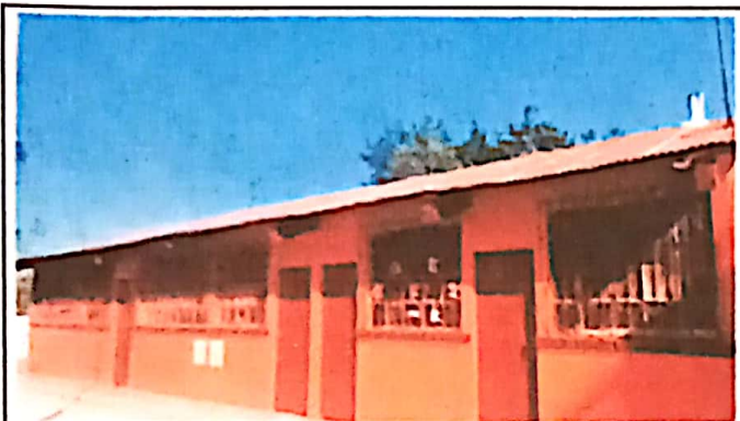
Foto 3: Sustrucción de lamina
