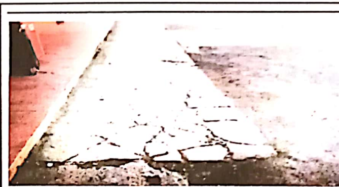
Foto 4: Reparación de piso de concreto
