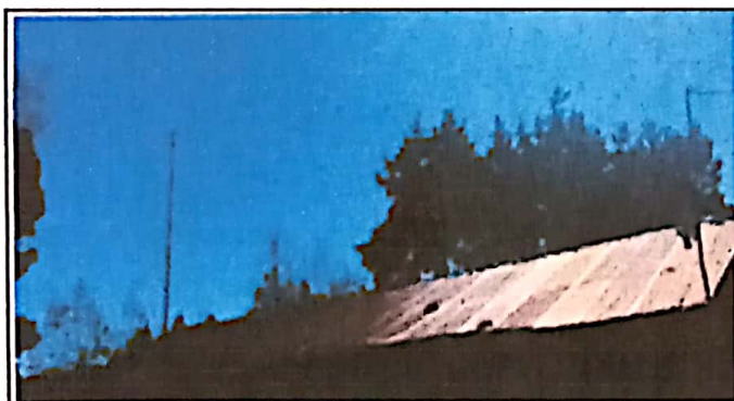
Foto 5: Sustrucción de lamina
